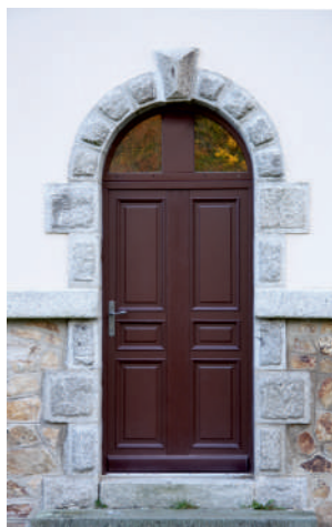
Porte bois cintré. À 1 vantail.
