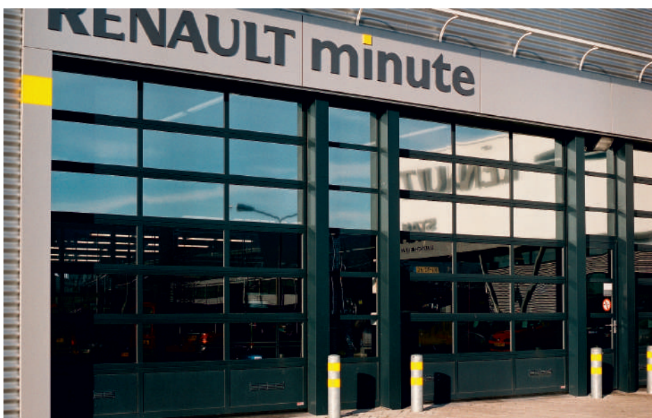
Portes de garage vitrées, rideaux et grilles métalliques pour commerce.
