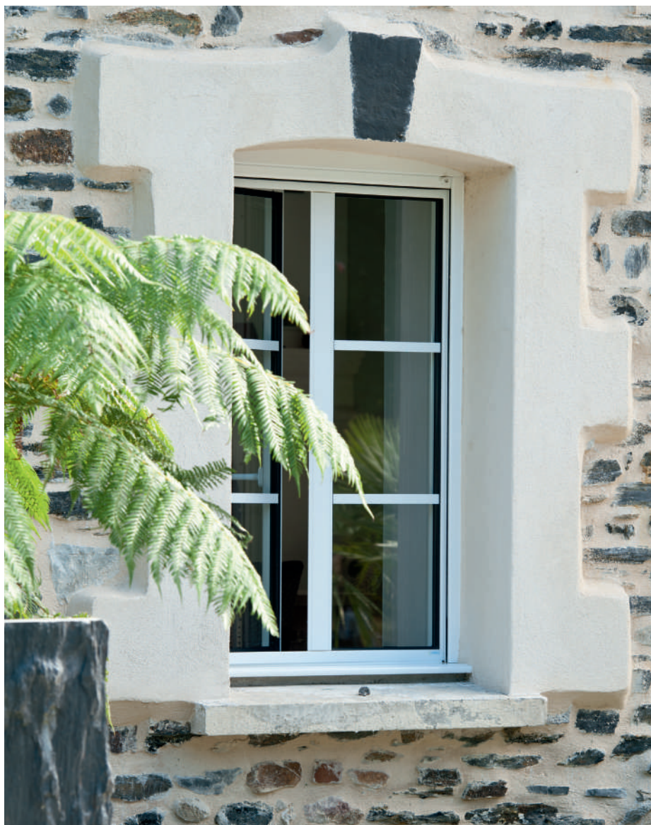
Fenêtre à ouvrant caché. 2 vantaux avec petits bois horizontaux et volet roulant intégré.
