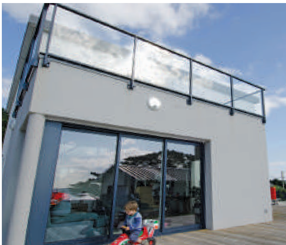
Garde-corps aluminium vitré pose en nez de dalle
