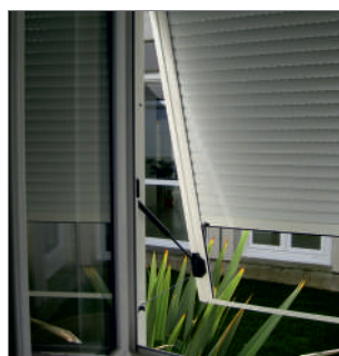
Volet roulant avec projection à l'italienne.
